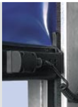
Børstetettinger beskytter mot trekk.
