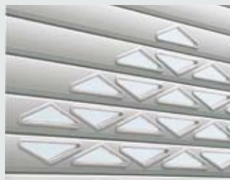
Trekantvinduer plassert i rombeform
